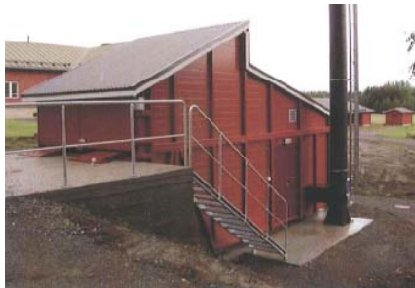
En image : un exemple de chaufferie bois .
