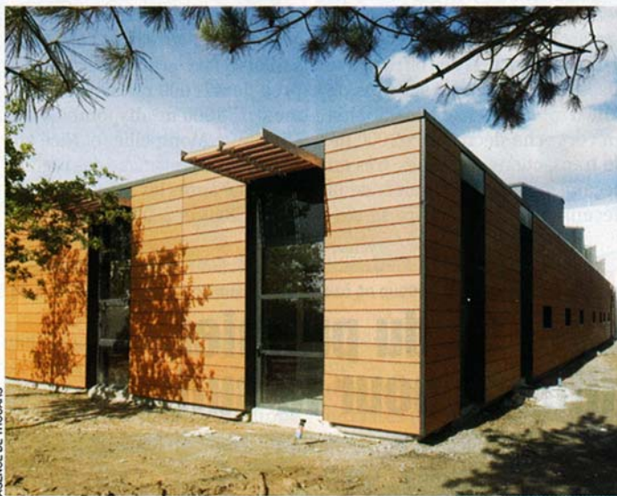
Un bâtiment exemplaire: les murs en briques, enduits de chaux puis isolés par un bardage en terre cuite, soutiennent une charpente en bois. L'usine est équipée de panneaux solaires, de capteurs thermiques et d'une chaudière biomasse.
