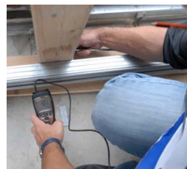
Test sur chantier
